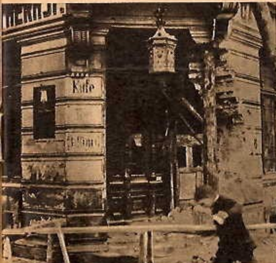
Durch Granatschuh beschädigtes Haus in München
