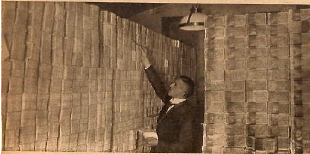
Bei den Bauten häufte sich 1923 das Papiergeld bis an die Decke
