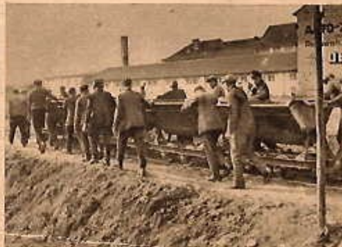
Koburger arbeitende Jugend auf der Baustelle. Es gilt, eine neue Ringstraße um die Stadt zu legen.
