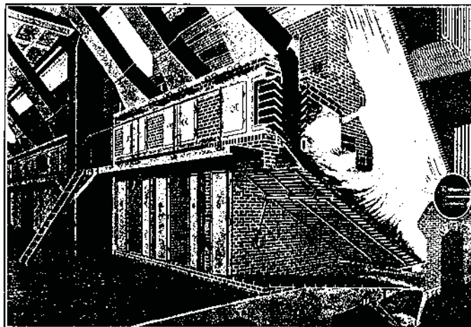
Topfsche Hochleistungsdampfung mit selbsttätigen Vorwärmungsbauteil an einem Stahlrohrkessel
