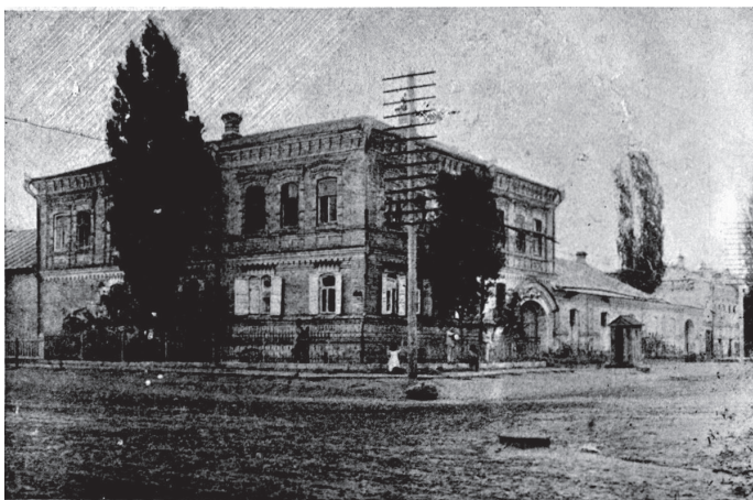
Budova Čeky v Novočerkasku
