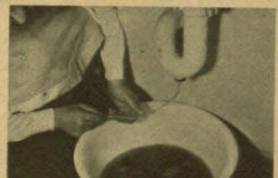
Mit einem kräftigen Draht wird aller Schmutz entfernt und die Schraube wieder angebracht
