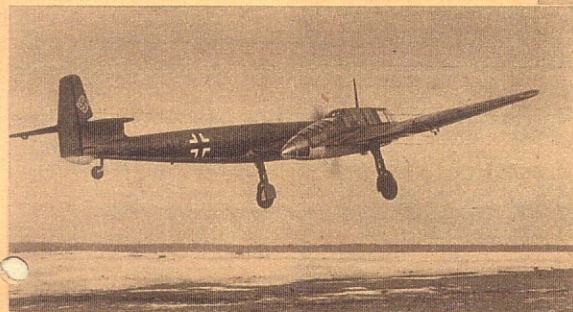
Die BV 141 kurz nach dem Start — noch mit ausgefahrenem Fahrwerk. Das für Sondereinsätze der Luftwaffe geschaffene Flugzeug, das mit BMW-Doppelstermotor ausgerüstet ist, zeichnet sich durch hohe Geschwindigkeit, große Wendigkeit und außergewöhnliche Steigleistung aus
