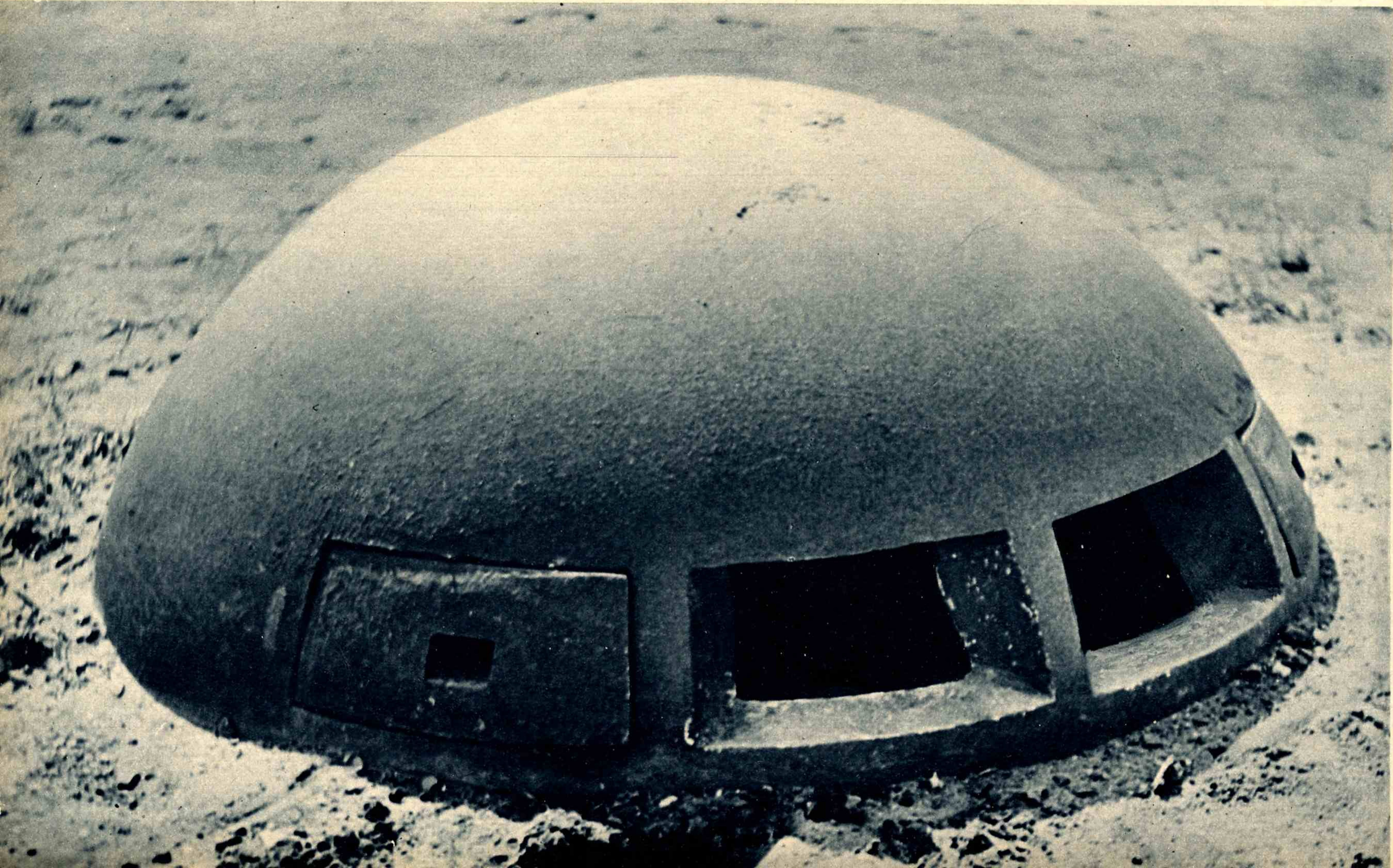
Unten: Diese Panzerkuppel eines Beobachtungsstandes ist das Auge eines großen Unterkunfts- und Kampfwerkes, das tief unter ihm in den Berg eingebaut ist
